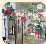
衝突防止ステッカー (1階事務室入口)
